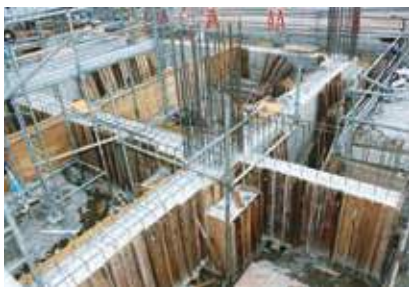
コンクリートが流し込まれた基礎
