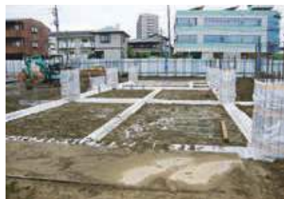
基礎の間に土が盛られました
