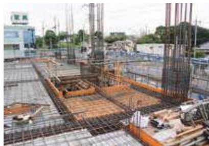
1階の天井(2階の床)になる部分です
