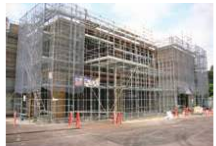
2階の大部分に型枠が組まれました
