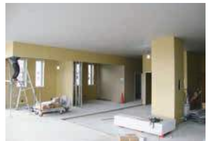
1階の内装工事も進んでいます
