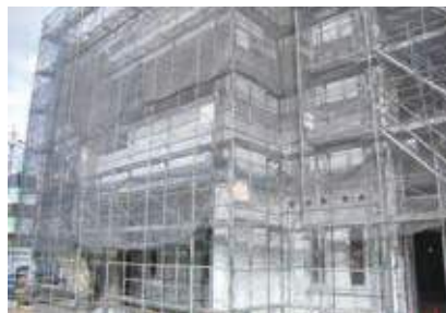
外壁の塗装が始まりました
