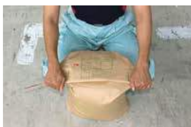
④さらにもう一回折り、三回目の折り目が袋に引かれている 緑色の横線に合うよう に折る。
