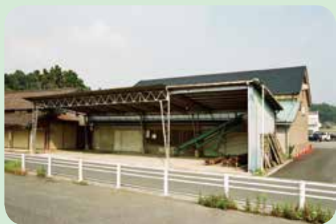
■旧大竹倉庫の全景 （平成12年撮影）
