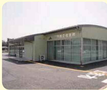
■建設当初の久住支所 (平成18年4月1日撮影)
